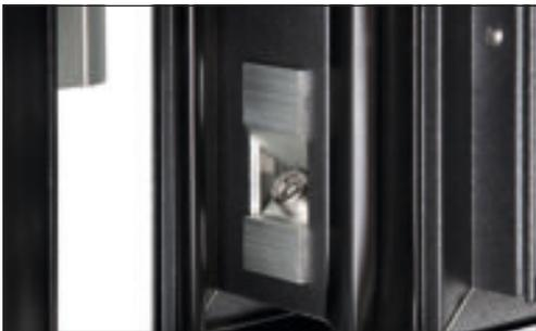
**Stabile Eckverbindungen** Profile auf Gehrung verschraubt, verklebt und verbalzt
